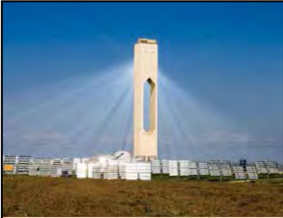
ಚಿತ್ರ 8: ಸ್ಪೇನ್‌ನಲ್ಲಿರುವ ವಿದ್ಯುತ್ ಸ್ಥಾವರ ಘಟಕ. ಕಲ್ಲಿದ್ದಲಿಗೆ ಬದಲಾಗಿ ಸೌರ ಶಕ್ತಿಯನ್ನು ಉಪಯೋಗಿಸಿ ಜನರೇಟರ್‌ಗಳಿಗೆ ಆವಿಯನ್ನು ಉತ್ಪಾದಿಸುತ್ತದೆ. ಗಾಳಿಬುಲರುುವ ಧೂಳಿನಿಂದ ಸೂರ್ಯಕಿರಣಗಳ ರೇಖೆ ಸ್ಪಷ್ಟವಾಗಿ ಕಾಣುತ್ತದೆ. ಕೃಪೆ http://en.wikipedia.org/wiki/PS10_solar_power_plant#/media/File:PS10_solar_power_tower.jpg
